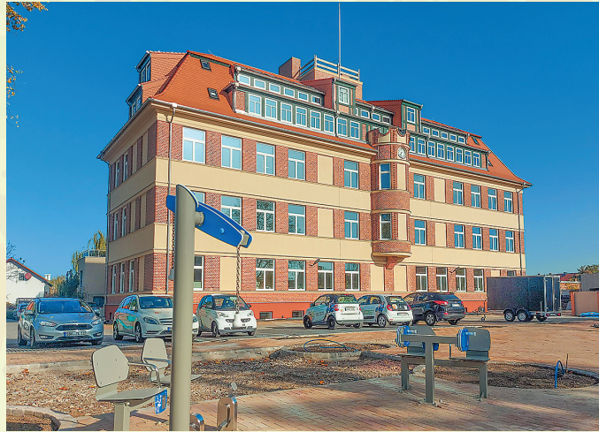
Bis Juli 2023 soll der Innenausbau abgeschlossen sein und auch die Außenanlagen erstrahlen bald in voller Pracht und laden zum Verweilen ein.
